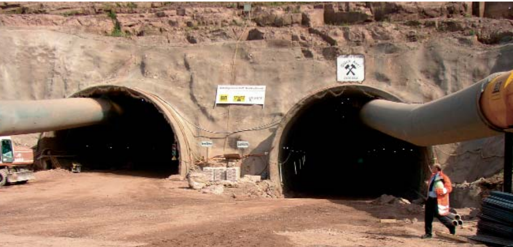
Baustelle A38: Blick in den Tunnel
