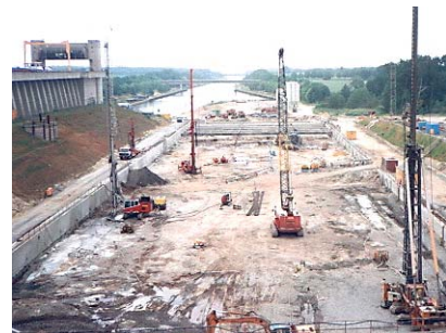
Baustelle der Schleuse II in Uelzen
