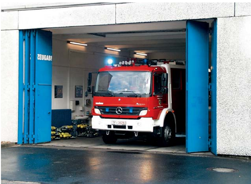
Fahrzeugabnahmehalle der LFS Celle
