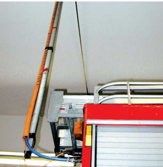
Druckluft- und Bordnetzeinspeisung von oben: Keine Stolpergefahr
